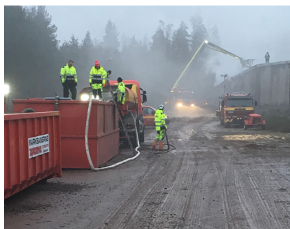
Mobilt reningsverk på plats vid eftersläckningsarbete.
